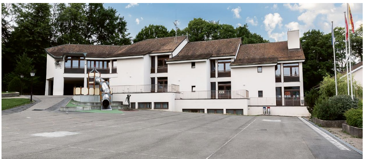
Fig. 1 L'école du Manoir de 1982 à 2023, soit avant les travaux d'extension.
